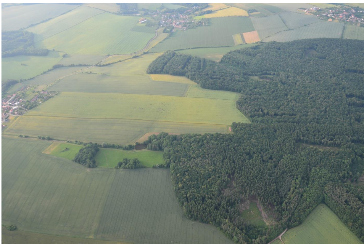
Pohled na pozemky určené k realizaci vodní nádrže N1 včetně přístupových komunikací a bezejmenný přítok Šišemky před revitalizací
